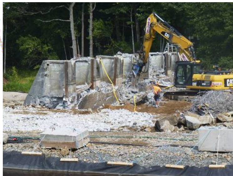
Utrivning av Hertings kraftverk i Åtran, fotograf Ingemar Alenäs
